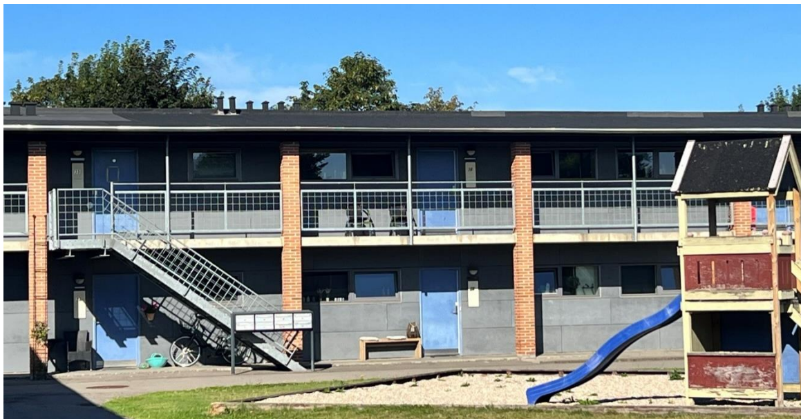
Tagfladerne er med ret lav hældning og beklædt med tagpap. Kipplanke er inddækket. Taget er uventileret.
