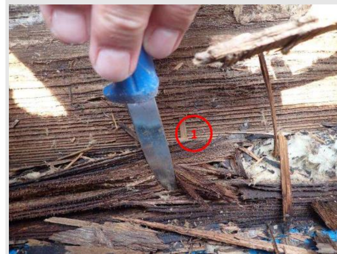
Billede fra svamperapporten fra 2022 viser trænedbrydning.
