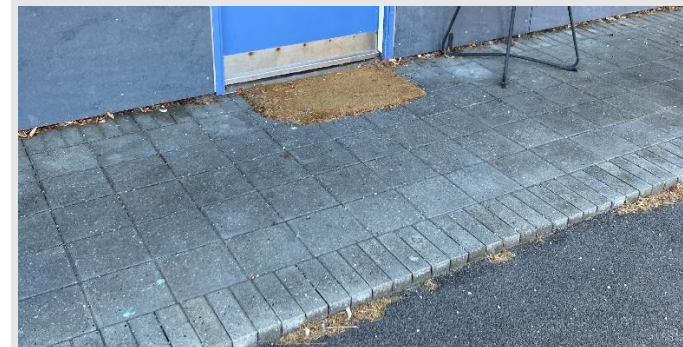
Der er ved indgangspartier lavet opkant fra asfalterede områder til overdækkede stigange.
