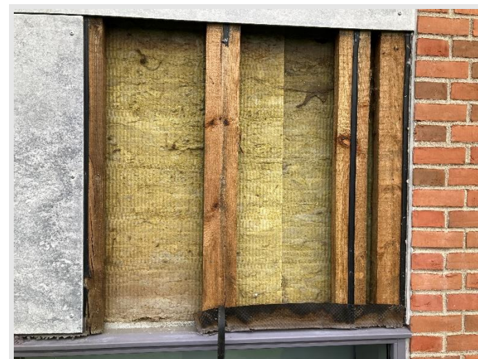
Konstruktionen blotlagt for at vurdere opbygning m.v.
